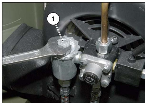
Bild 76 Kraftstofffilter (Zuleitung Brenner)
