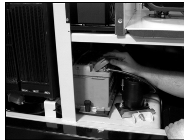
Irrota miinusnapajohdon kiinnitys
