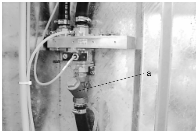
K.9 kép: Vízelosztó a szennyfogó
