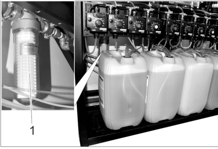
1 Filter frostskyddspump
