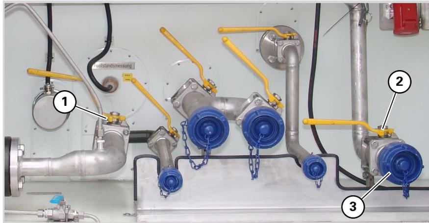
Bild 19 Entnahmearrangement mit Druckerhöhungspumpe
