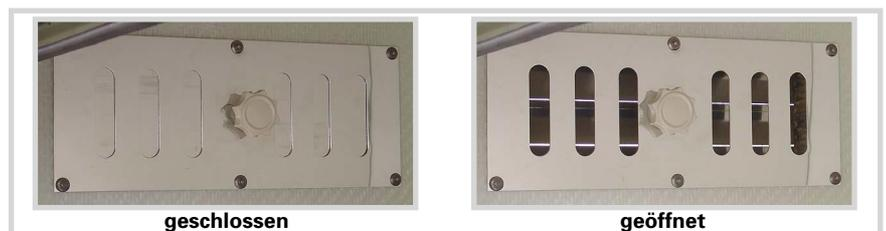
Bild 11 Lüftungsöffnungen
