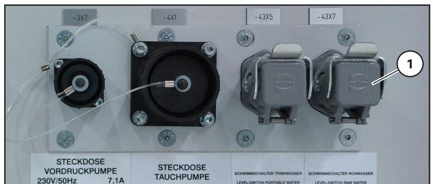
Bild 43 Anschluss Füllstandmeser RW-Zwischenspeicher
